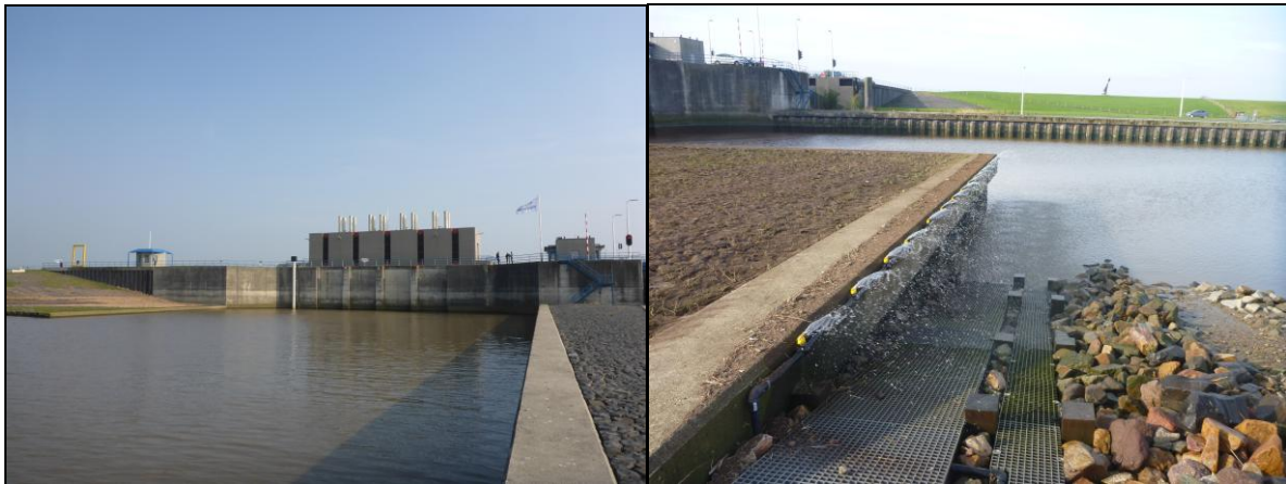
Afbeelding 1a & b: Het sluisencomplex van Nieuwe Statenzijl vormde lange tijd een groot obstakel voor de intrek van vissen vanuit de Eems-Dollard naar de Westervoldse Aa. Door de realisatie van kattenluiken en een aalgoot zijn de vismigratie mogelijkheden op deze locatie sterk verbeterd.
