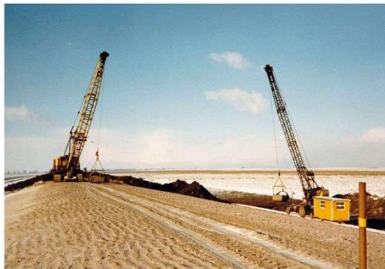
Aanbrengen kleilaag op zandlichaam (januari 1985)
