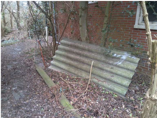
3. asbestverdacht golfplaten tegen de zuidoostelijke muur van de woning (vanuit het oosten)
