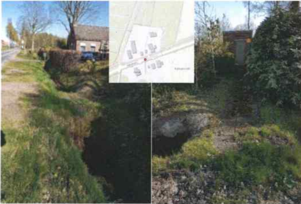
Foto 7: te verdiepen inliggende duiker.
