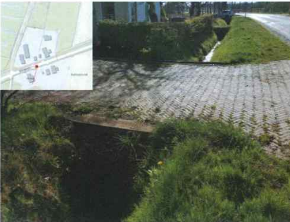
Foto 6: te verdiepen inliggende duiker.
