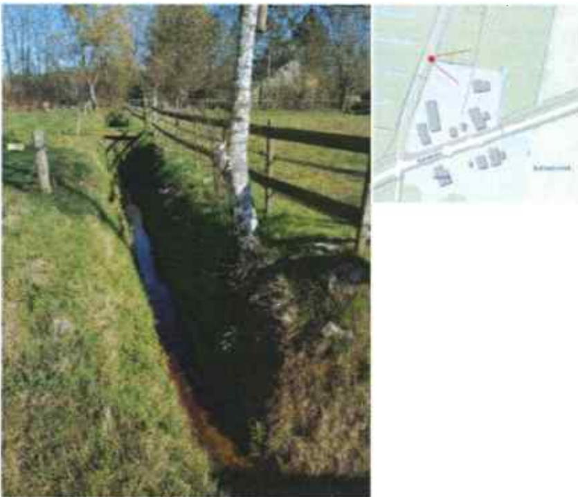
Foto 3: te verruimen inliggende duiker.
