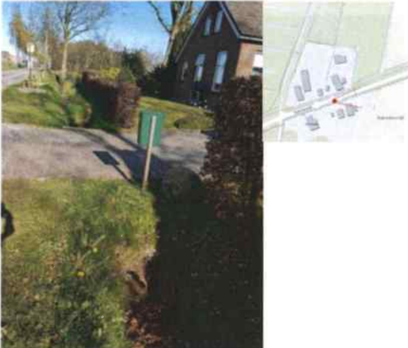
Foto 8: te verdiepen inliggende duiker.
