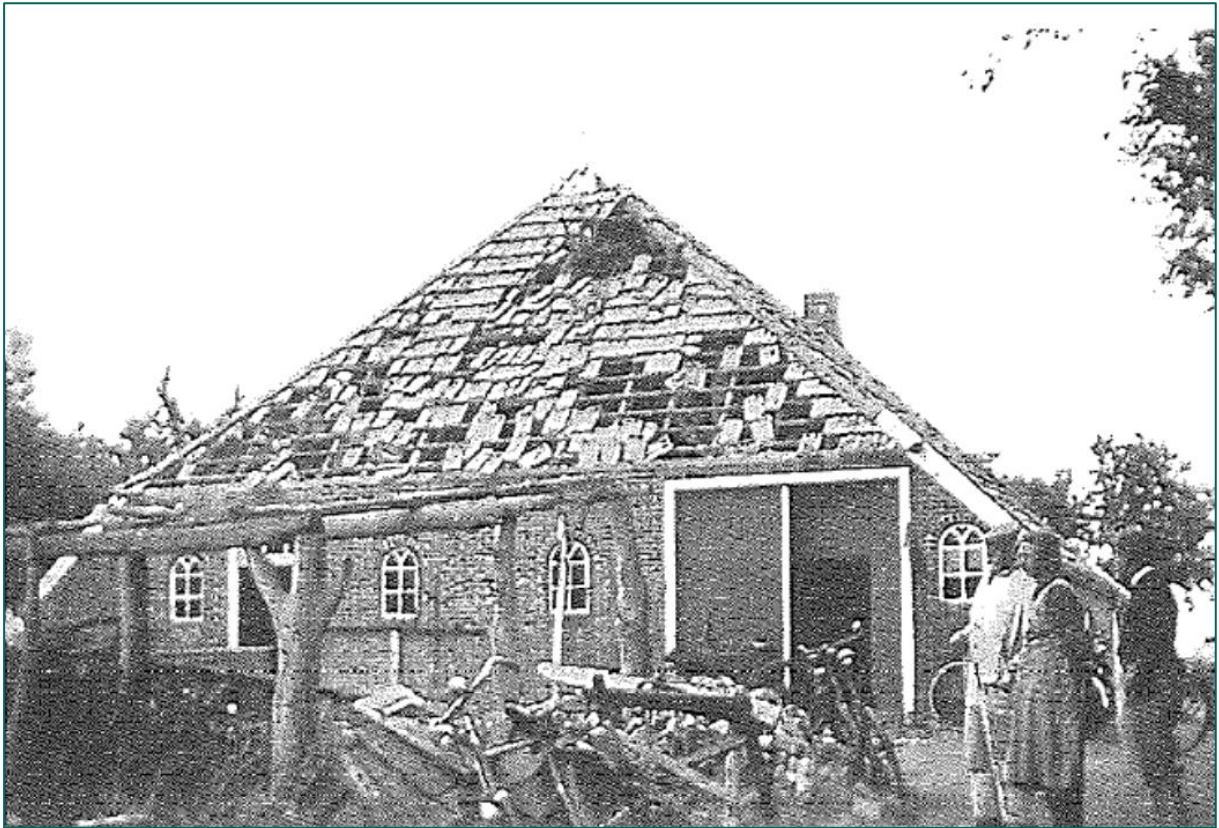
Figuur 2: Schade na bomafworp op 9 juli 1942 (Bron: Bezetting en bevrijding van Haren, 1940-1945 , p. 31).
