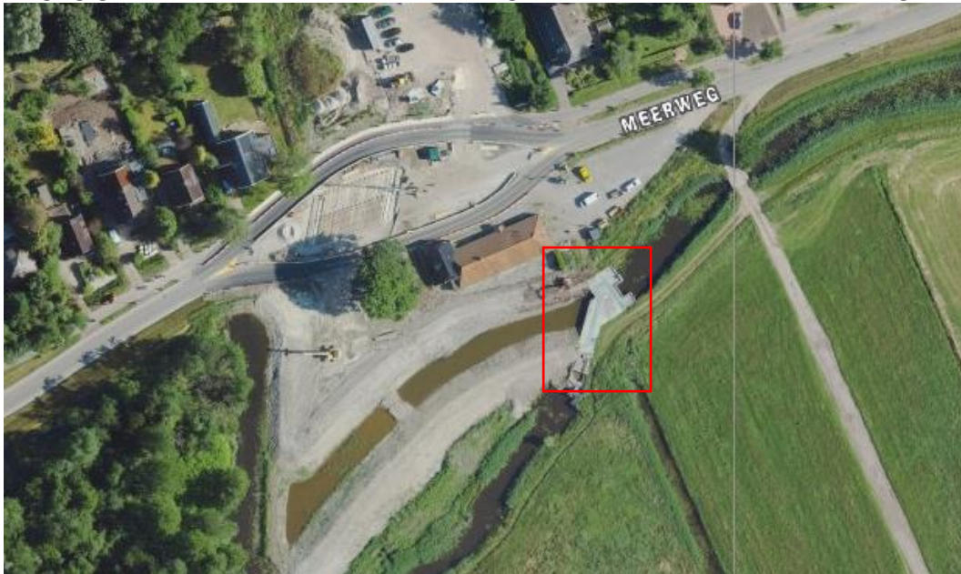
Figuur 13. Op te hogen gemaal in rood kader (bron Street Smart, Cyclomedia, d.d. november 2022)
