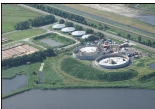
Afbeelding 1.2. Aanleg RWZI Foxhol
