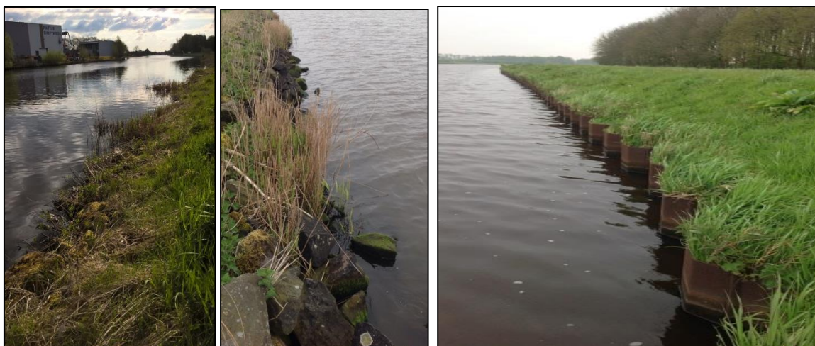
Figuur 4.18. Locaties 4102-06 en 05 met enige vegetatie en Locatie 2102-08 met damwand
