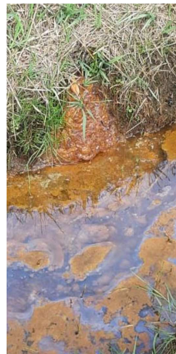
Figuur 2-21 Kwel en buisdrainage met sterke roestvorming (Foto RHDHV 2019).
