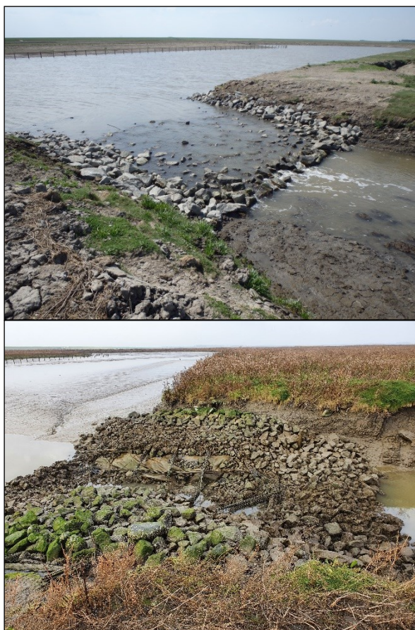
Figuur 2.3 Ontwikkeling van het dwarsprofiel boven over de drempel in de monding van de Klutenplas in de eerste drie jaar na aanleg. De drie profielen zijn niet elk jaar langs precies dezelfde lijn opgenomen. De foto rechtsboven is van 23 mei 2018, een maand nadat de Klutenplas werd blootgesteld aan de invloed van het getij. De foto rechtsonder is van 9 november 2020 en laat zien hoe de drempel door onderloopsheid is aangetast.
