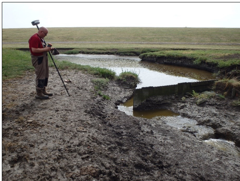
Figuur 4.3 Achterloopsheid bij de stuw tussen de aansluiting van de dijksloot met zwet III. Foto 14 augustus 2020.
