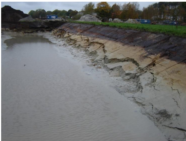
Figuur 12: Micro- instabiliteit van een talud
