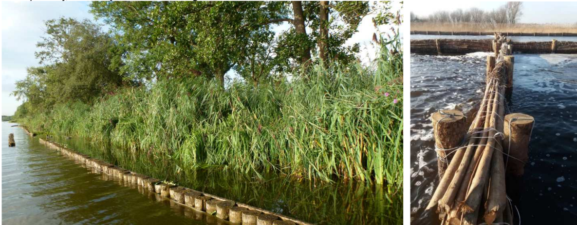
Links palenrij, rechts rijshoutbeschoeiing
