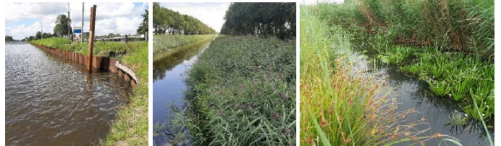
Van links naar rechts: beschoeide oever, rietoever, slenk met vooroever.
