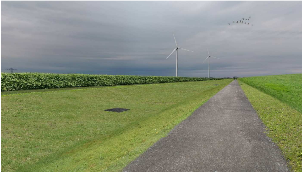
Figuur 16 Beeld naar het noorden, de meest zuidelijke putdeksels van de drainage is zichtbaar
