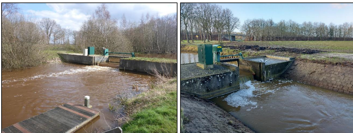
Afbeelding 5.17 a&b. Stuwen zijn in Westerwolde de meest belangrijke oorzaak van waterstagnatie. De stuw in de Ruiten Aa bij Renneborg zal als onderdeel van het project Renneborg – Ter Walslage verwijderd worden. De stuw in het Veelerdiep ten noorden van het dorp Veele blijft staan maar is wel recentelijk voorzien van een nieuwe vispassage.
