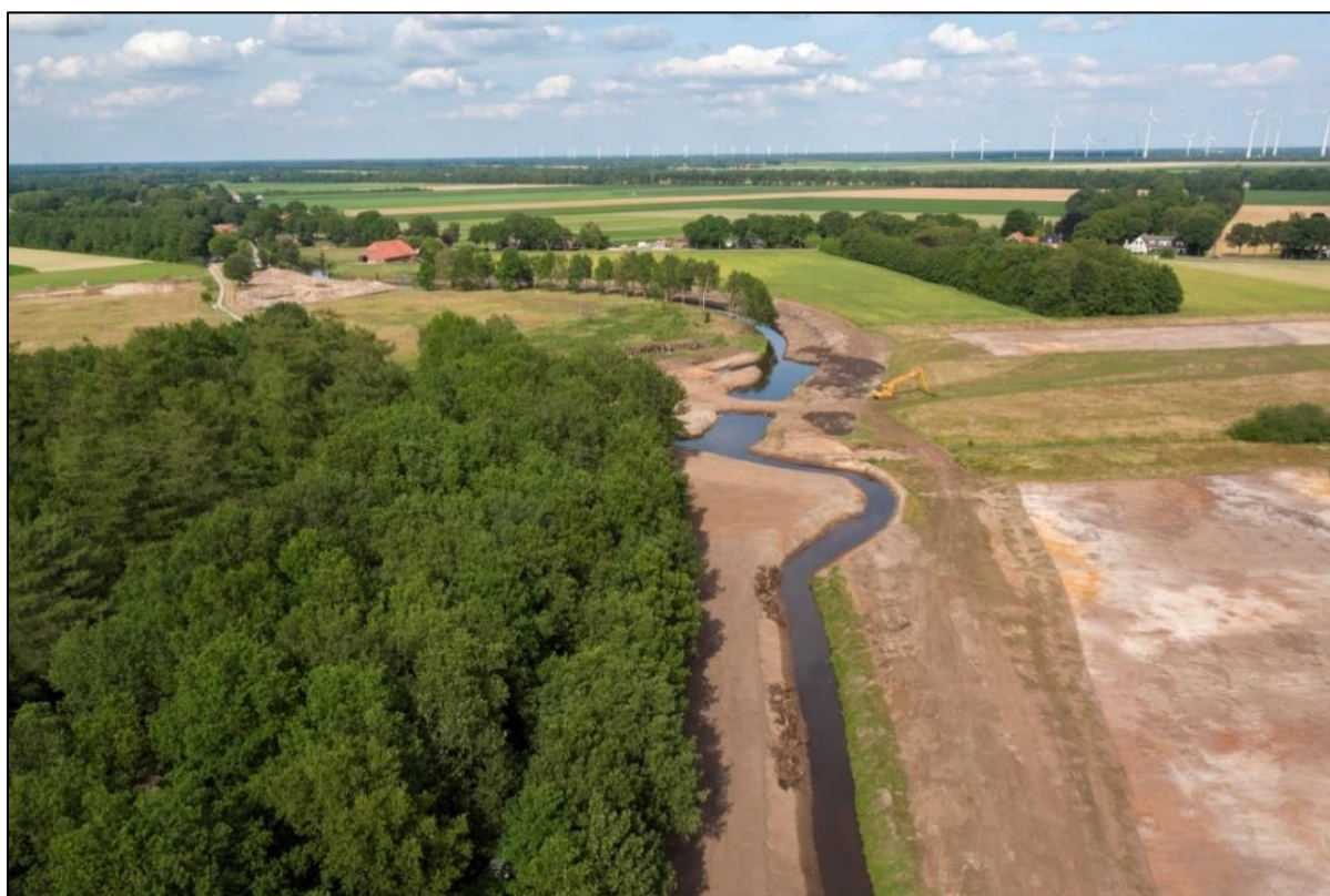
Afbeelding 4.1. In het herinrichtingsproject Renneborg – Ter Walslage wordt gewerkt aan de hermeandering van de Ruiten Aa.
