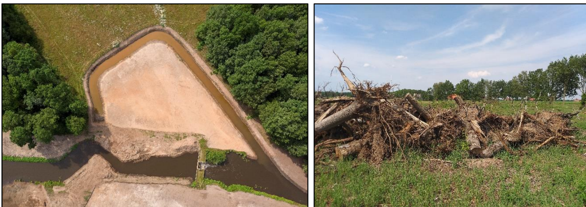
Afbeelding 6.4.a&b. Bij de beekherstelwerkzaamheden worden de brede genormaliseerde beeklopen grotendeels gedempt en vervangen door smallere natuurlijke dimensies. Bovenstaande foto (a) toont de aanleg van een nieuwe meander aan de noordzijde. Aan de zuidzijde zijn de stuw en een deel van de brede genormaliseerde loop nog zichtbaar. De stobben die vrijkomen tijdens het project (b) worden hergebruikt in de beek om zo meer diversiteit in habitats te creëren.
