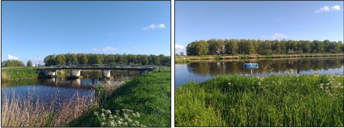
Afbeelding 2.1.a&b Ter hoogte van het buurtschap De Bult stroomt de Westerwoldse Aa onder de brug door en komt daar samen met het huidige Winschoterdiep (oude tak van de Pekel Aa). Hier ligt de grens van het KRW waterlichaam Westerwoldse Aa Zuid. Vanaf dit punt stroomt het water binnen het KRW waterlichaam Westerwoldse Aa Noord af in de richting van de zeesluizen bij Nieuwe Statenzijl.
