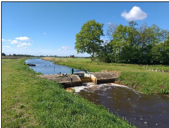
Afbeeldingen 4.6. a & b. Bij EVZ Ter Wisch is het niet mogelijk om de Ruiten Aa volledig te hermeanderen. Om het landbouwkundige peilbeheer uit te kunnen voeren liggen hier nog een drietal stuwen in de beek. Om de vrije migratie van vissen te waarborgen zijn alle drie de stuwen voorzien van vispassages.
