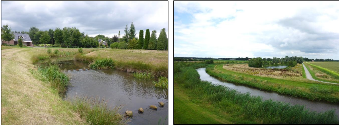
Afbeelding 6.5.a&b. Door middel van vispassages, zoals hier in Het Schot in Ter Apel, zijn de migratiemogelijkheden voor vis en macrofauna hersteld. De natuurvriendelijke oevers langs de Runde bieden een geschikt leefgebied voor veel vegetatie minnende soorten. Ook zoogdieren als de otter kunnen deze route gebruiken om zich te verplaatsen tussen verschillende natuurgebieden.
