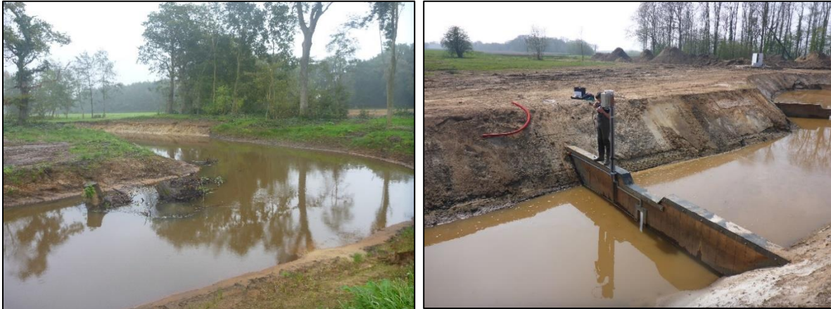
Afbeelding 6.1 a&b. De Westerwoldse Aa stroomt bij Wessinghuizen (a) door een zandig gebied heen. Hier ontstaan steile oeverwallen in de buitenbochten. In de beek zijn op enkele locaties stobben ingebracht ten behoeve van de habitatdiversiteit. Op de bodemval bij stuw Wedde zijn PIT-antennes gemonteerd. Hiermee kan het waterschap de migratie van gezenderde vissen door de vispassage volgen.
