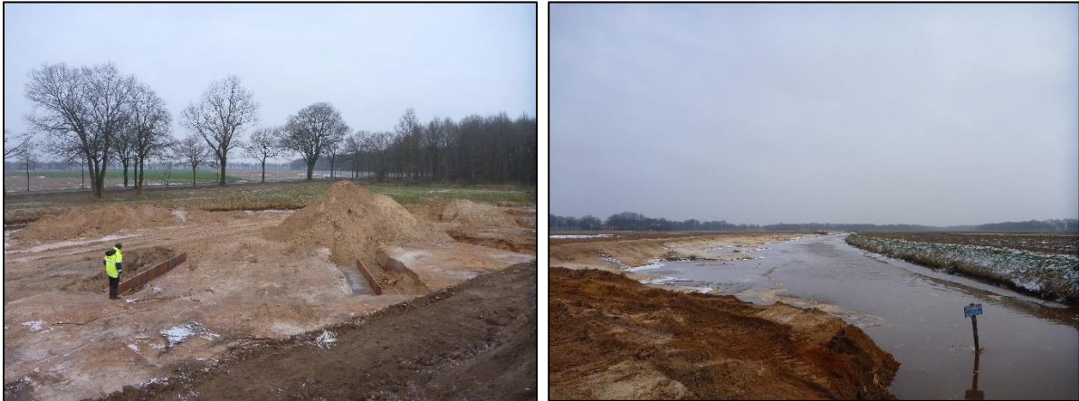
Afbeelding 6.3.a&b. De 3 vispassage zijn “in het droge” gebouwd en later pas aangetakt aan de beek (a). De Ruiten Aa is hier aan een zijde voorzien van een 10 à 15 meter brede NVO, de overzijde biedt ruimte aan een onderhoudspad voor de uitvoering van het noodzakelijke beheer- en onderhoud aan de hoofdloop.
