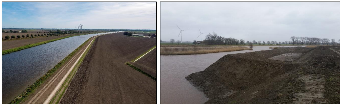
Afbeelding 6.1. a & b. Bij de uitvoering van de dijk en oeverherstel projecten langs de Westerwoldse Aa zijn over een grote lengte natuurvriendelijke oevers gerealiseerd (foto a). De reconstructie van enkele oude geschutsopstellingen naast de dijk maakte deel uit van dit project (foto b).
