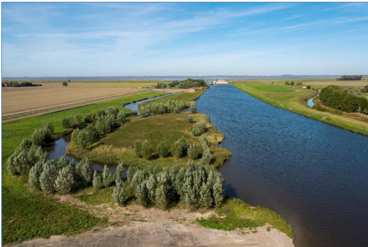
Afbeelding 5.1. De Westerwoldse Aa Noord is ten behoeve van de waterafvoer- en scheepvaart functies gekanaliseerd en over gedimensioneerd. Het terugbrengen van de oorspronkelijke getijdebewegingen of het herstellen van een smalle stromende beekloop is in de huidige situatie niet mogelijk zonder de andere gebruiksfuncties in het gebied aan te tasten. Het sluizencomplex van Nieuwe Statenzijl vormt hierbij een harde barrière tussen de zoute Eems-Dollard en de zoete binnenwateren. Wel is het mogelijk door het aanbrengen van ruime nevengeulen extra leefruimte te creëren voor diverse planten en diersoorten. Deze maatregel is onder andere gerealiseerd aan de westzijde van de hoofdloop bij Nieuwe Statenzijl.
