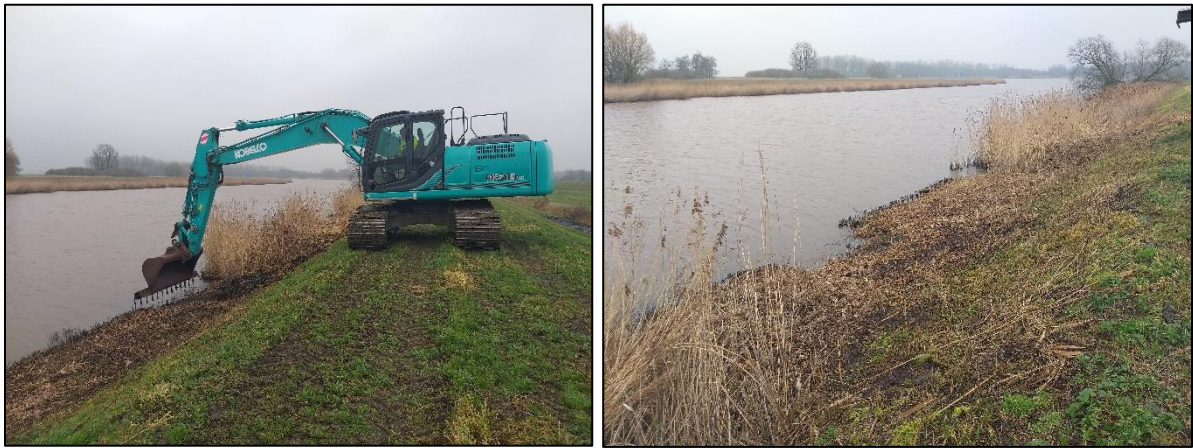
Afbeelding 6.2. a & b. Naast de fysieke inrichting van oevers is ook de uitvoering van het juiste beheer en onderhoud van groot belang om de maximale ecologische ontwikkeling te kunnen bereiken. Om te voorkomen dat de natuurvriendelijke oevers volledig volgroeien met helofyten worden deze met een lage frequentie “gekrabt” met een speciaal ontworpen kraanbak (foto a). Hiermee worden open plekken in de rietvegetatie gecreëerd die ruimte bieden voor de ontwikkeling van diversiteit aan oever- en ondergedoken planten (foto b). Deze variatie is ook erg waardevol voor de macrofauna en visstand.
