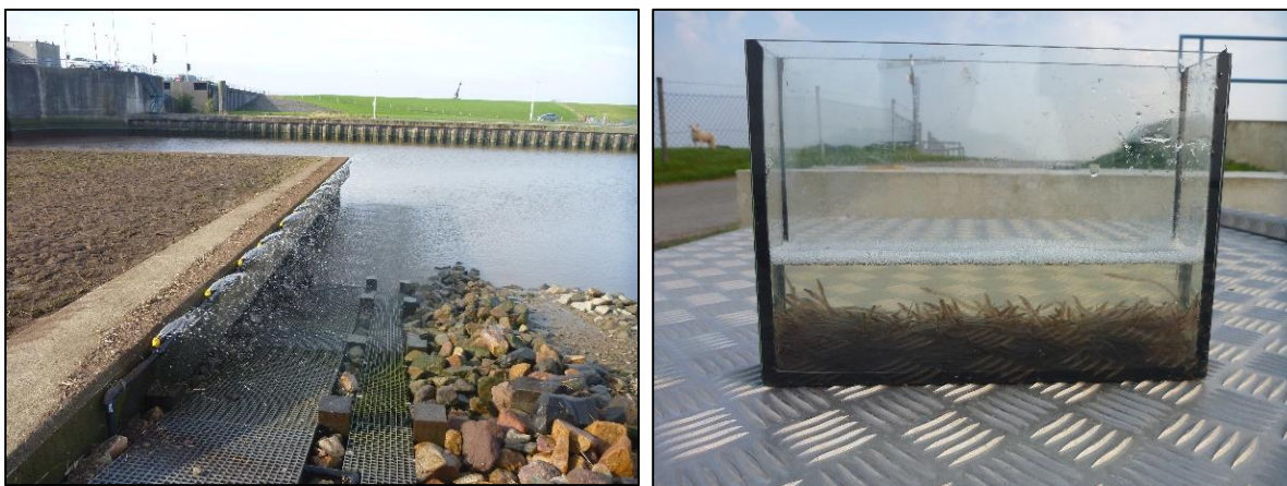
Afbeelding 5.3.a&b. Bij de ingang van de aalgoot wordt er door middel van een rij sproeiers een zoetwater lokstroom gerealiseerd waarmee de glasalen de ingang goed kunnen vinden. Boven aan de dijk is een vangconstructie aangelegd waarmee de optrekkende glasalen geteld kunnen worden. Hier passeren tijdens de glasaaltrek grote aantallen glasaaltjes.
