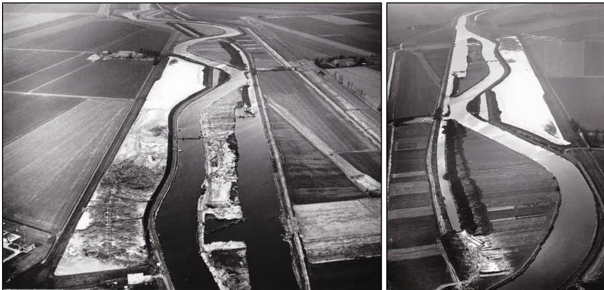
Afbeeldingen 2.1. a & b Kanalisatie werkzaamheden aan de Westerwoldse Aa begin december 1970 (Foto's genomen door "Aerophoto Eelde" / www.nazatendevries.nl )
