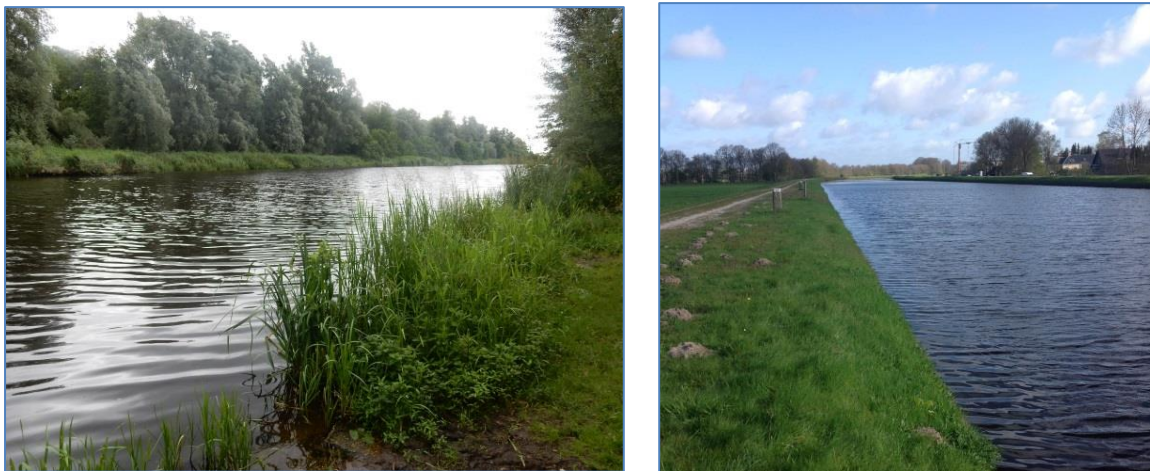
Afbeelding 2.2: Locatie 2102-08 met oeverzone met vegetatie en locatie 2102-03 met damwand zonder oeverzone
