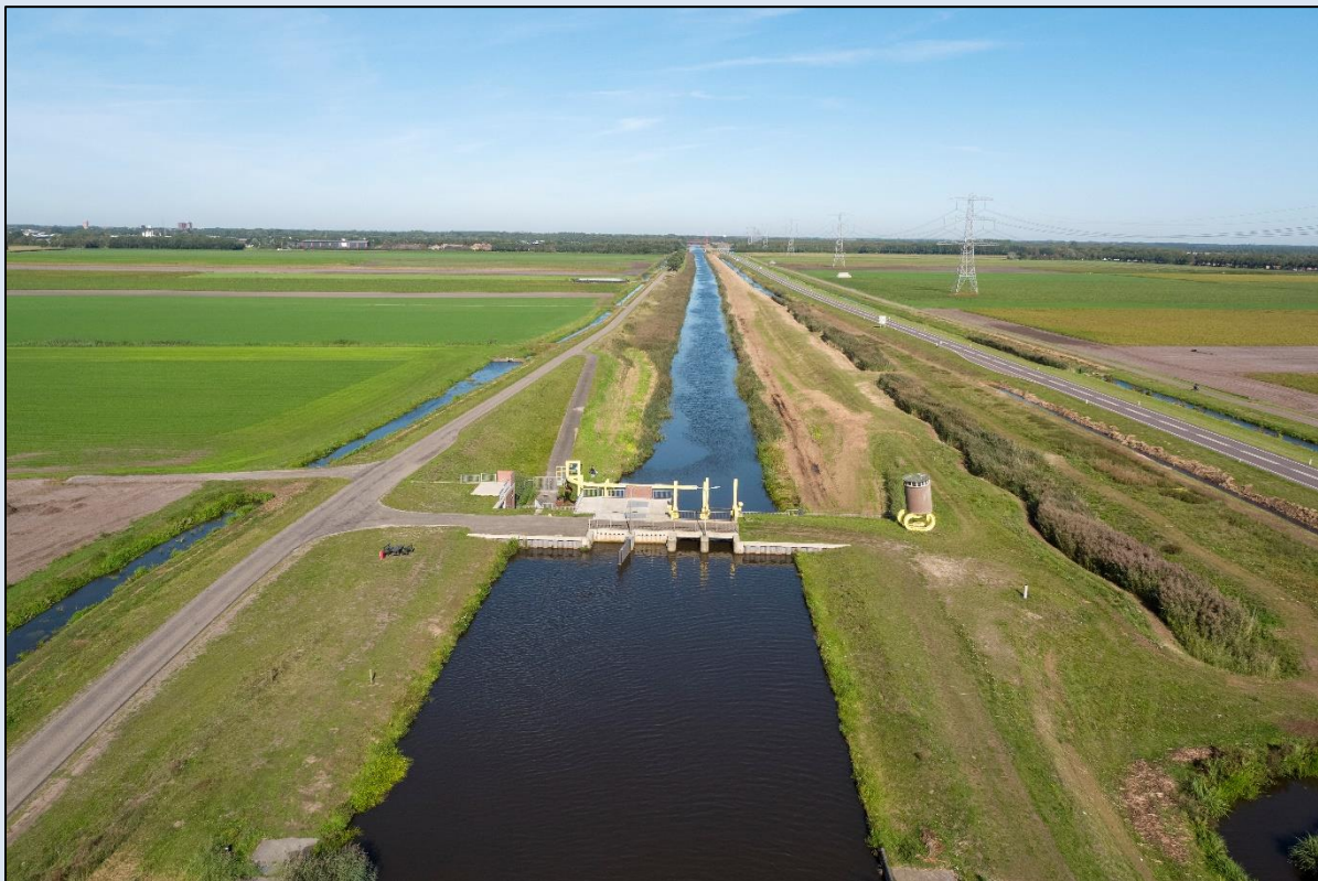
Afbeelding 2.3. Aanvoergemaal Vennix in het A.G.Wildervanckkanaal.
