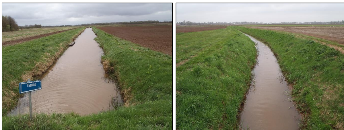
Afbeeldingen 2.2. a & b Het Pagediep en de Mussel Aa zijn in het verleden genormaliseerd en hebben daarbij landbouwkundige profielen gekregen die gedimensioneerd zijn op een snelle aan- en afvoer van water.
