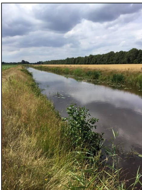
Foto 4.2. Locatie 1104-13; Voedingsleiding Ruiten Aa Kanaal
