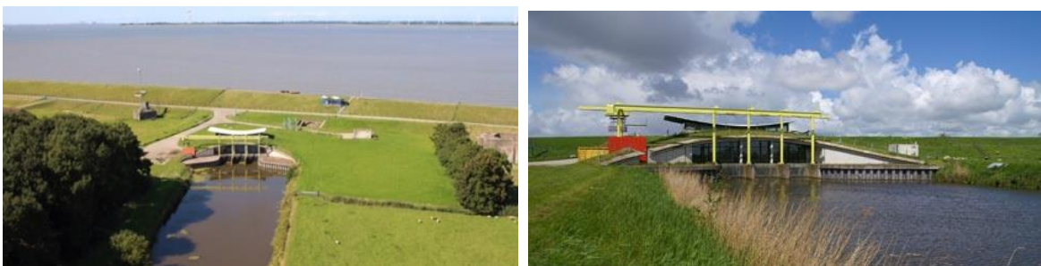
Figuur 2.7 Zeegemaal Fiemel, waarmee Kanaal Fiemel afwatert op de Dollard
