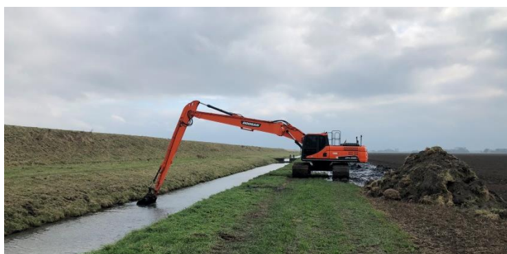
Afbeelding 5.1. Baggeren Kanaal Fiemel in 2018
