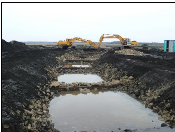
Afbeelding 6.1.a&b Als onderdeel van het LOFAR project is het Achterste Diep weer optrekbaar gemaakt voor beekvissen. Hiervoor zijn een aantal vispassages aangelegd (a). Na aanleg is in 2011 gestart met de monitoring (b) door middel van fuikenonderzoek. Naast grote aantallen Riviergrondels zijn ook een aantal Serpelingen gevangen. Deze laatste is een zeer kritische beekvis en indicator voor een goede waterkwaliteit.
