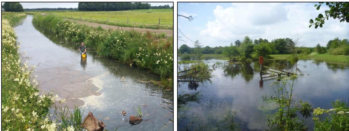
Afbeelding 7.13.a&b. Het genormaliseerde Rolderdiep (a) is een typisch voorbeeld van een overgedimensioneerde beek met een normprofiel. De dimensies zorgen ervoor dat inundaties bij hoge waterafvoeren vrijwel niet voorkomen. Dit is in het Gasterensche Diep (b) wel het geval.
