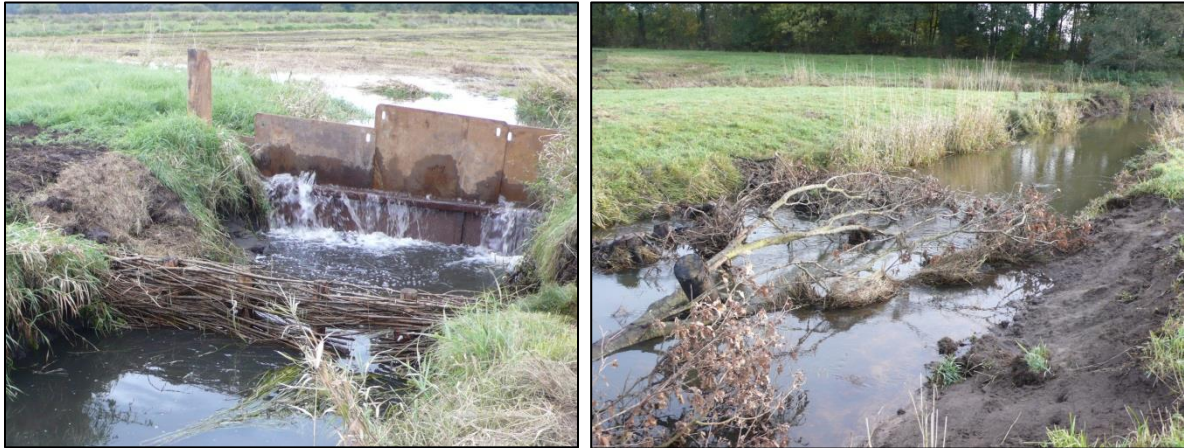
Afbeelding 8.3.a&b In de onderzoekstrajecten in het Gasterenschie Diep zijn kleine dammetjes van rijshout (a) en (delen van) bomen in de beek aangebracht. Hiermee worden de waterstanden verhoogd waardoor de stroomsnelheden afnemen en sediment de kans krijgt te bezinken tussen het houtige materiaal.
