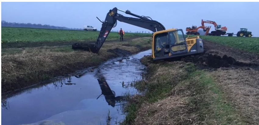
Instabiele taluds door graafschade
