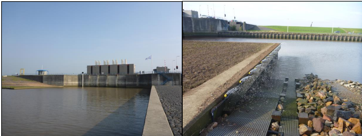
Afbeelding 1a & b: Het sluizencomplex van Nieuwe Statenzijl vormde lange tijd een groot obstakel voor de intrek van vissen vanuit de Eems-Dollard naar de Westerwoldse Aa. Door de realisatie van kattenluiken en een aalgoot zijn de vismigratie mogelijkheden op deze locatie sterk verbeterd.
