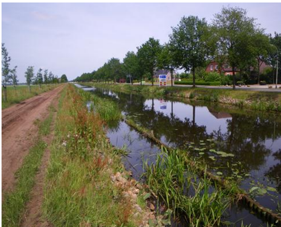
Foto: Door de aanleg van natuurvriendelijke oevers in de kanalen worden extra mogelijkheden gerealiseerd voor vissen om te paaien en voedsel te zoeken.
