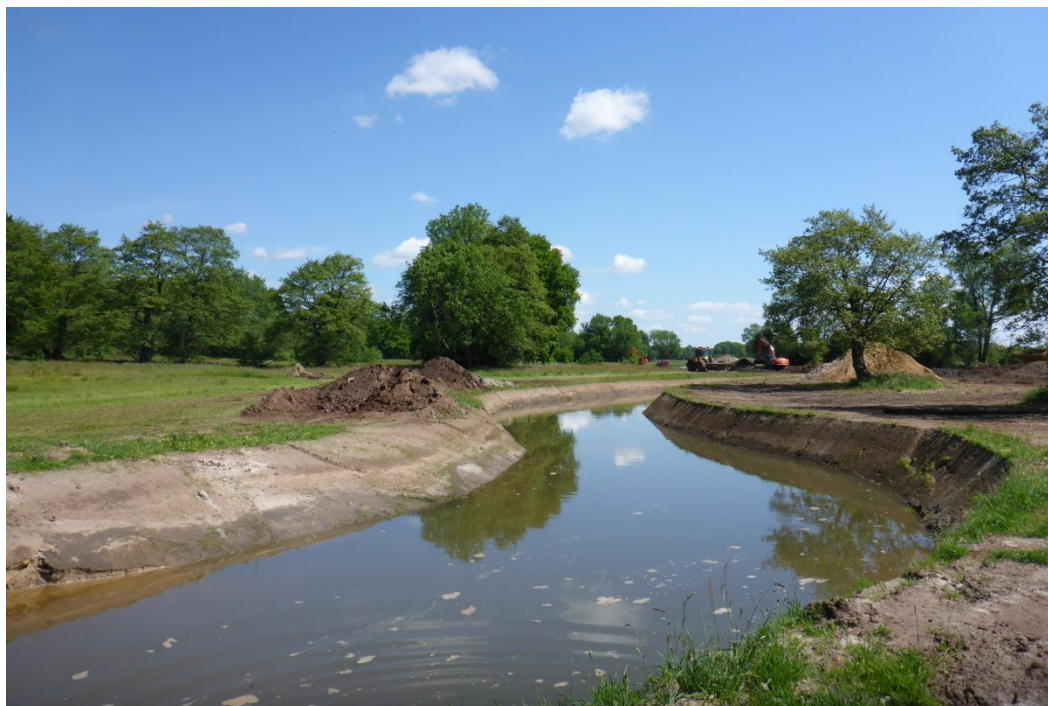
Graafwerk bij de inrichting van het Deurzerdiep, 2015
