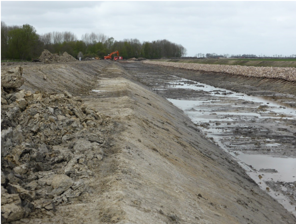
Proef met preventieve maatregel steenstort tegen graafschade door muskusratten bij de vaarverbinding Blauwe Stad
