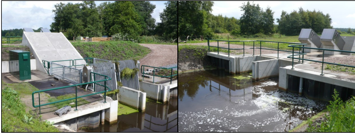
Afbeelding 4c & d: Gemaal Ennemaborgh is voorzien van een tweetal visveilige vijzels van de firma Landustrie. Uitgevoerde visveiligheidstesten laten zien dat deze vijzels goed functioneren.
