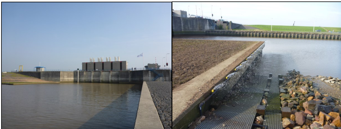
Afbeelding 1a & b: Het sluisencomplex van Nieuwe Statenzijl vormde lange tijd een groot obstakel voor de intrek van vissen vanuit de Eems-Dollard naar de Westervoldse Aa. Door de realisatie van kattenluiken en een aalgoot zijn de vismigratie mogelijkheden op deze locatie sterk verbeterd.
