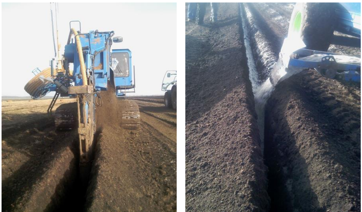
Figuur 3.3 Aanleg van de drainage. Links: de draineermachine graaft de sleuf en legt de drain erin. Rechts: de sleuf wordt gevuld met goed doorlatend zand.
