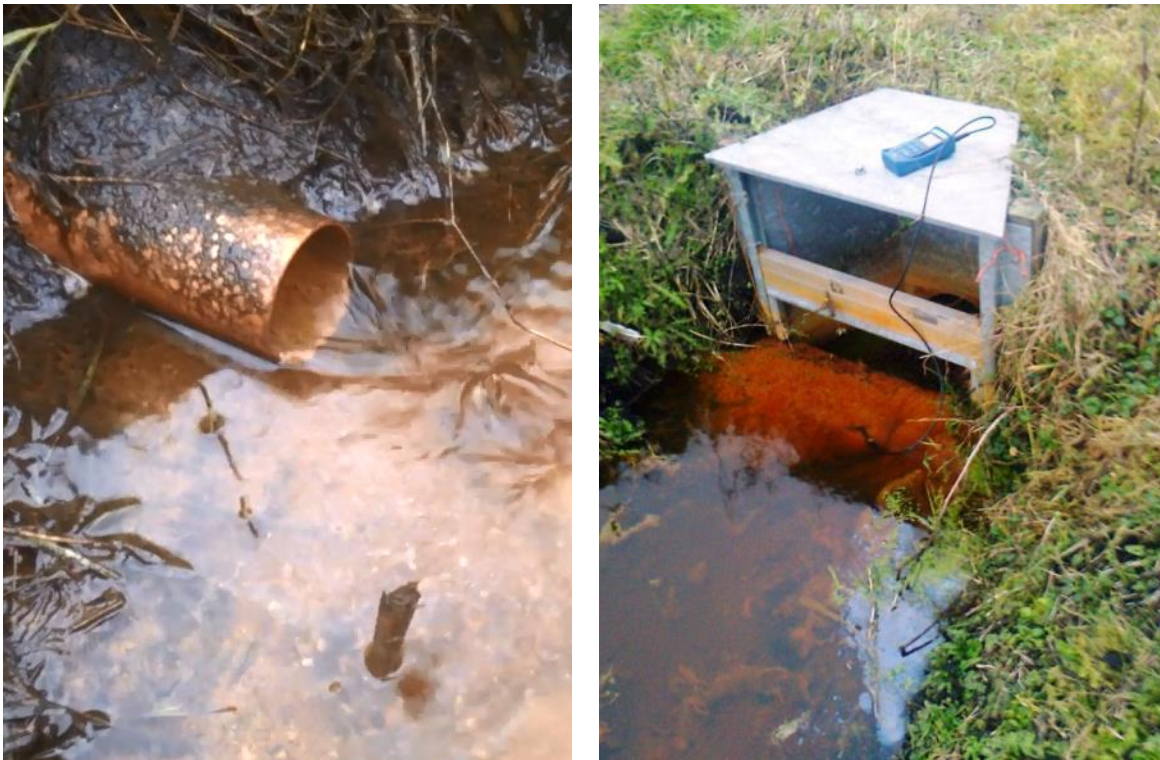
Figuur 3.4 Drain uistroompunt (links) en regelbare stuw (rechts). Beiden met neerslag van ijzeroxide-vlokken. Bij de stuw ook een bacterievliesje rechts in de sloot, kenmerkend voor kwel.
