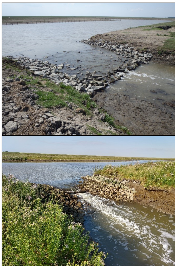
Figuur 2.3 (Boven) Vergelijking van het dwarsprofiel boven over de drempel in de monding van de Klutenplas op 5 september 2018 en 21 augustus 2019. De twee profielen zijn niet langs precies dezelfde lijn opgenomen. De foto rechtsboven is van 23 mei 2018, een maand nadat de Klutenplas werd blootgesteld aan de invloed van het getij. De foto rechtsonder is van 21 augustus 2019 en laat het beginnende verval van de drempel zien.
