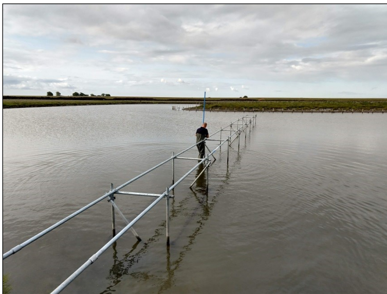
Figuur 2.2 De meetbrug in de NO-hoek van de Klutenplas. Op de foto wordt de peilbuis geïnstalleerd (31 aug. 2018).
