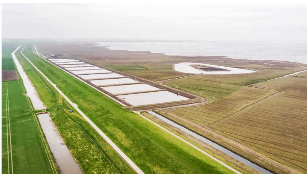
Figuur 1-4 Kleirijperij locatie kwelder. De ringdijken van het depot zijn gemaakt van klei uit de Klutenplas, verder op de kwelder
