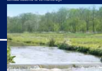
Deze speciale vispassages in de Ruiten Aa kunnen ook door kano's gepasseerd worden.
