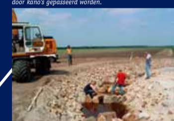
Constructie van een vispassage in de Runde.
