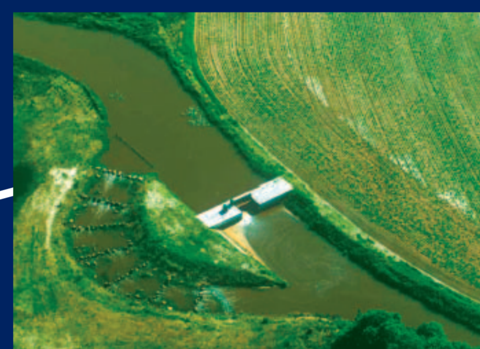
Deze stenen vispassage in de Ruiten Aa is om een stuw aangelegd.
