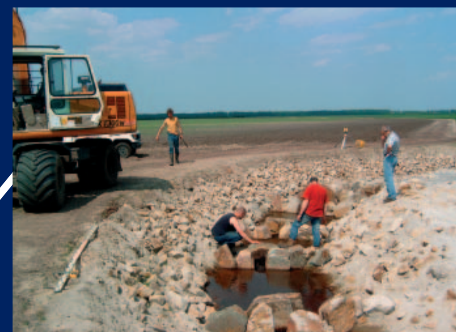
Constructie van een vispassage in de Runde.
